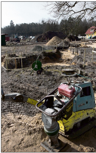
Sandberge türmen sich im Hintergrund, ganz vorne wird der neue Weg befestigt.
